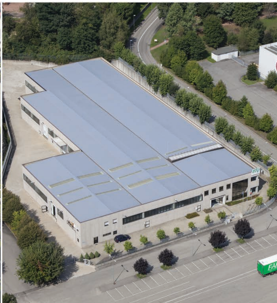
Stabilimento FAR 3 - San Maurizio d'Opaglio - Produzione - Magazzino - Uffici
